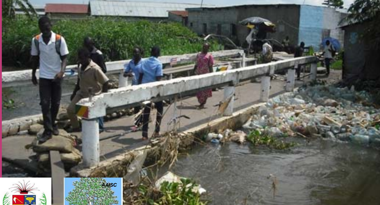
Pré-identification de projets concernant le volet « aménagement urbain » : ici, passerelle de la rue Owando
