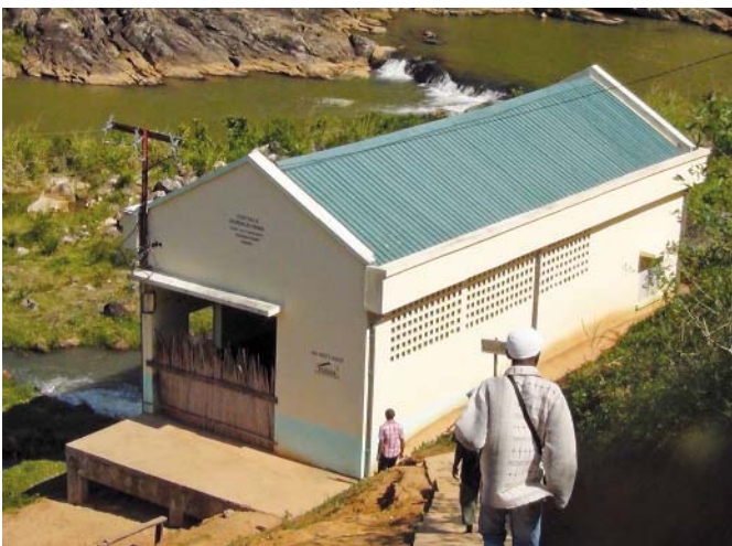
Bâtiment de la centrale
