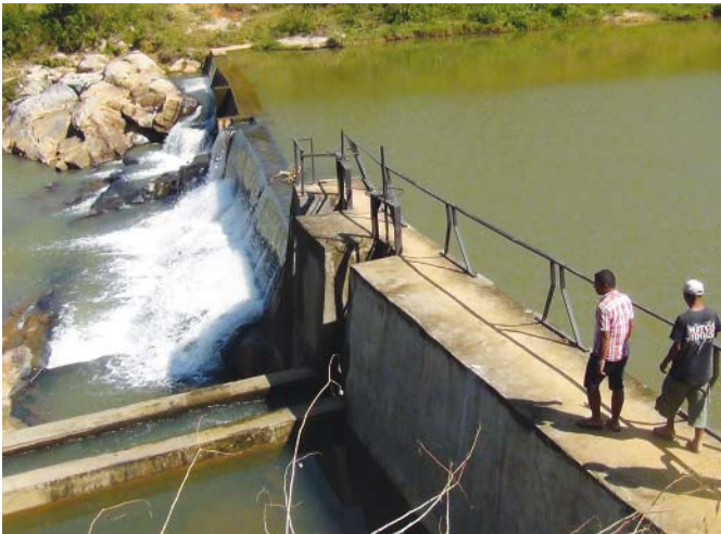
Barrage de Sahasinaka
