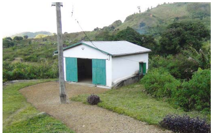
Bâtiment de la centrale de Tolongoina
