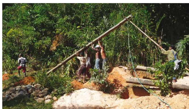
Levage de poteau électrique
