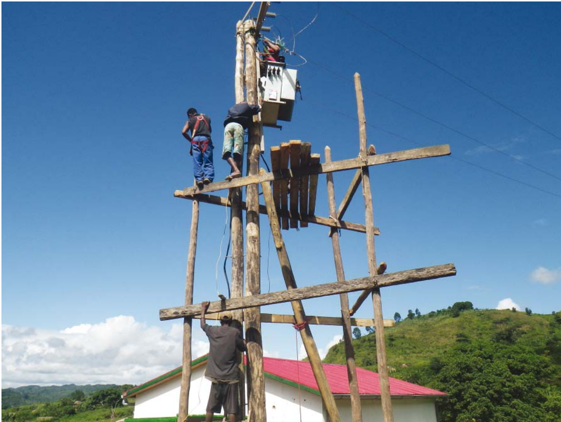
Montage du transformateur élévateur auprès de la centrale de Tolongoïna
