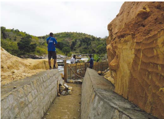
Construction du canal d'amenée à Sahasinaka
