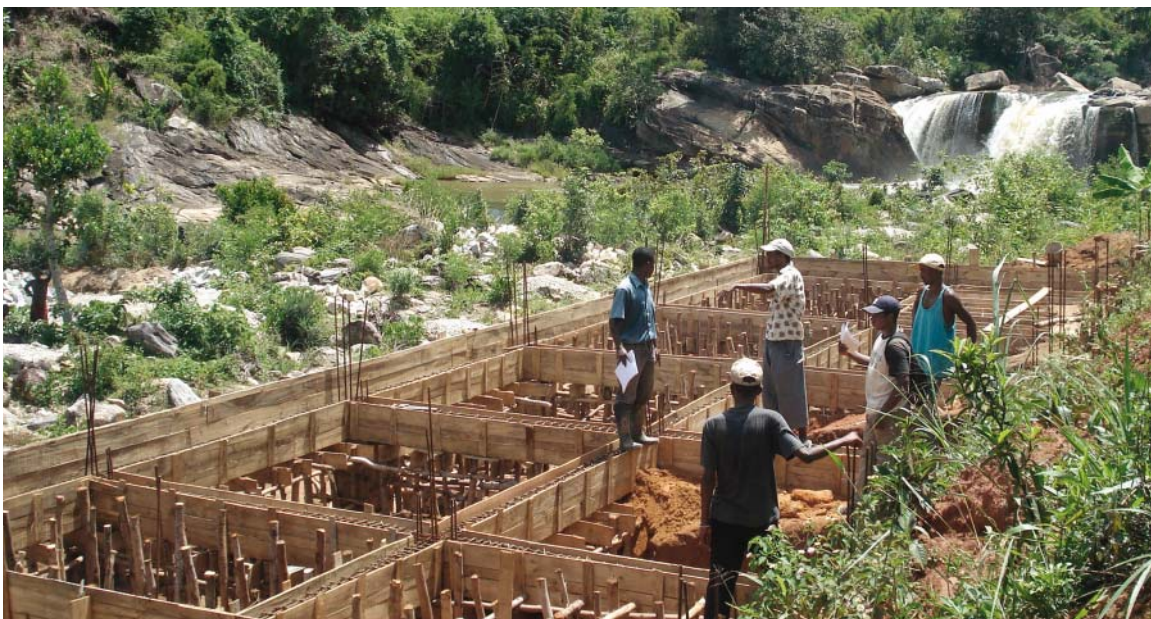
Construction du bâtiment de la centrale de Sahasinaka
