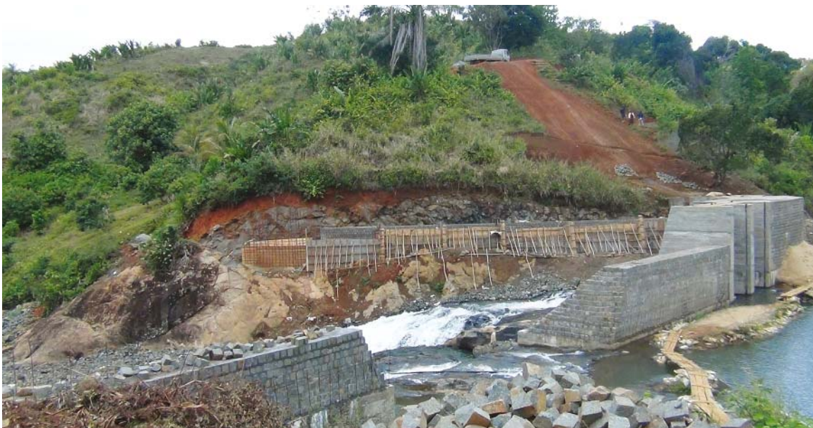
Barrage de déviation de la chambre de décantation de la centrale d'Ampasimbe-Onibe
