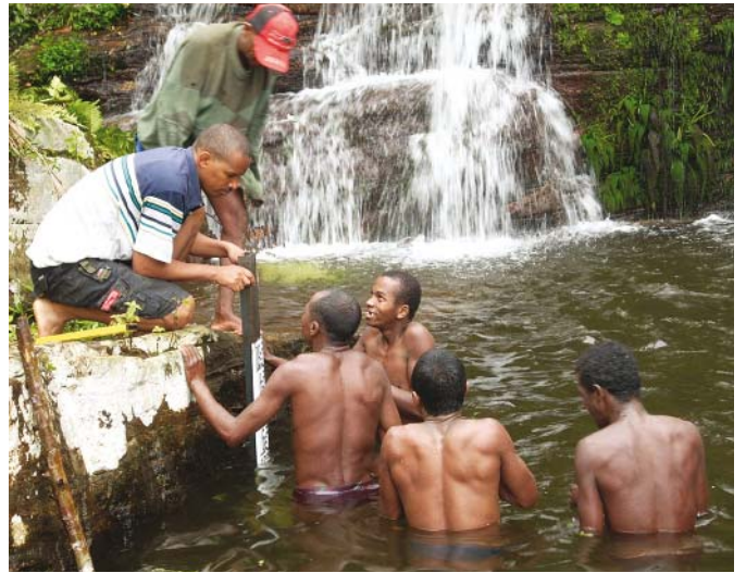
Installation des échelles limnimétriques à Tolongoina
