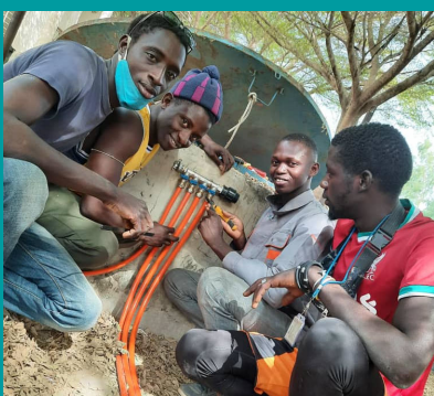
Installation et maintenance de systèmes irrigués connectés au photovoltaïque
